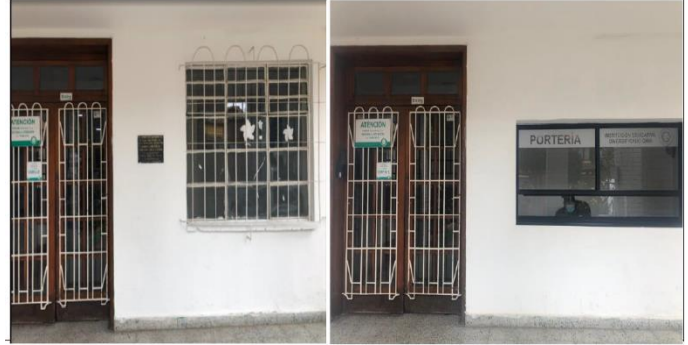
SEDE PRINCIPAL : ADECUACION PORTERIA
